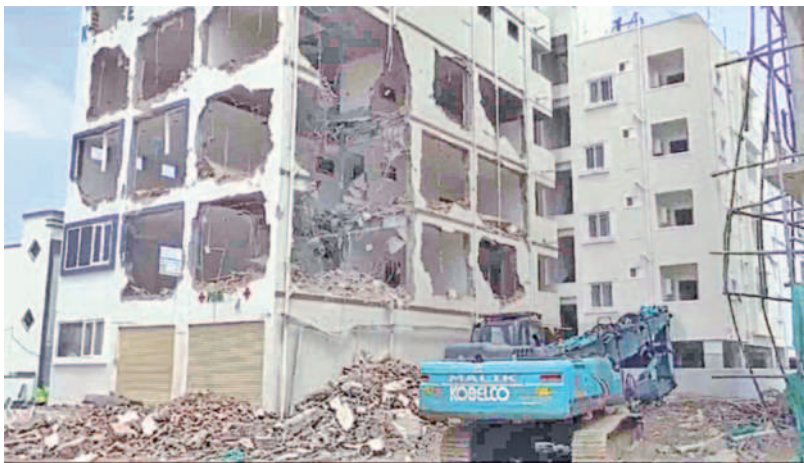
సంగారెడ్డిలో ఆదివారం అక్రమ నిర్మాణాలను కూల్చివేస్తున్న హైద్రా
